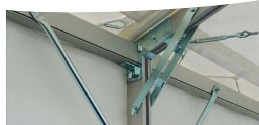
Klappbinder für einfache Montage - Eckstreben für höchste Stabilität
