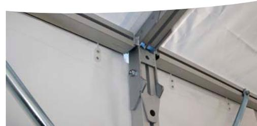
Einfachste Montage durch selbstsicherndes Klappgelenk und Federverschluss an der Traufe
